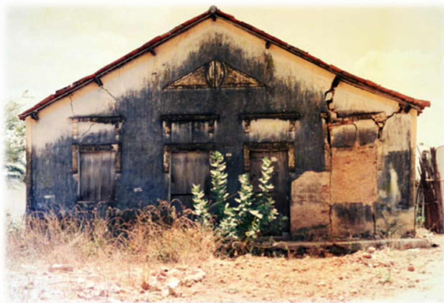
Figura 10: A Casa em ruínas em 1992. Acervo: Fundação Casa Grande – Memorial do Homem Kariri.
