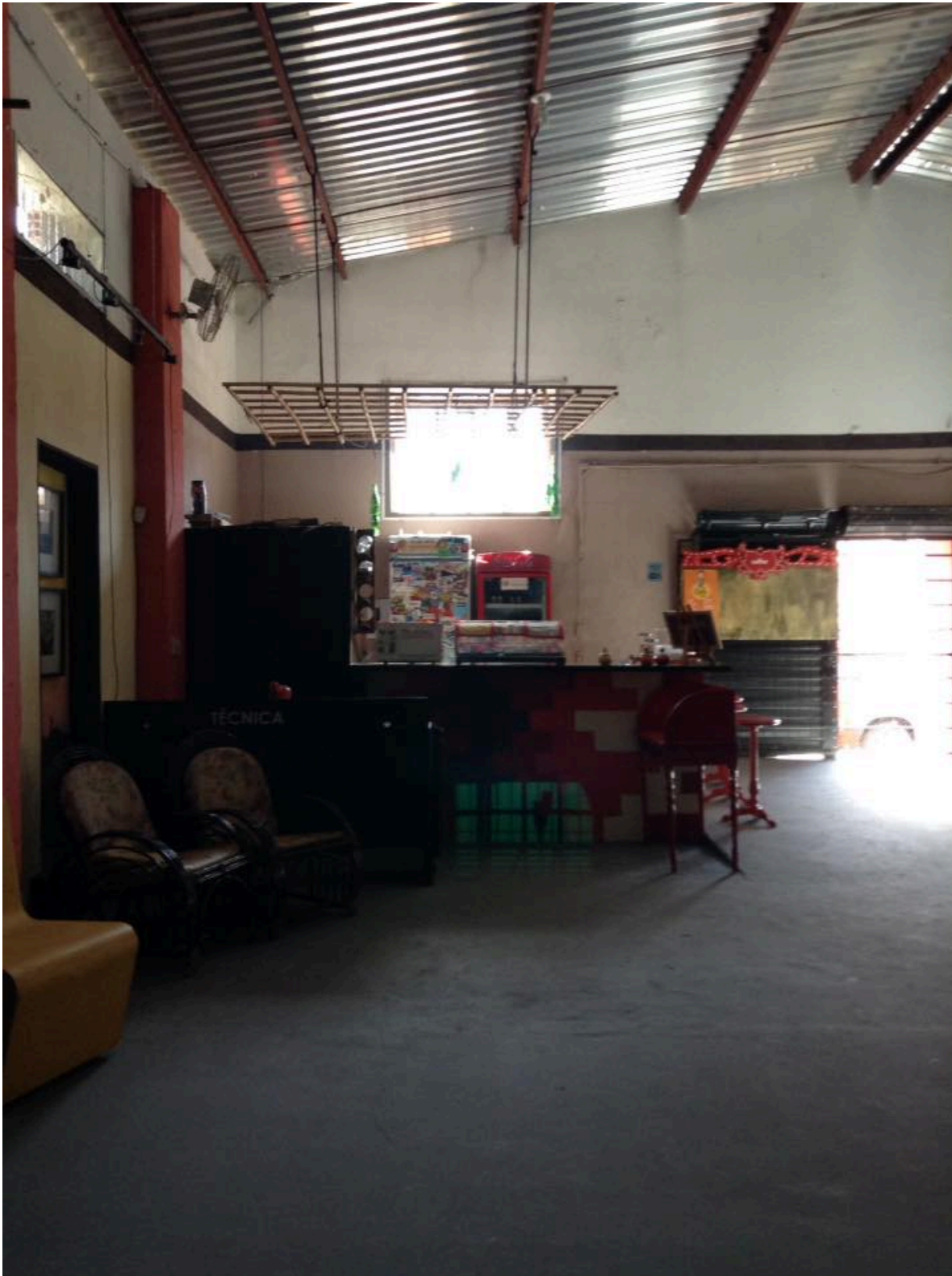
Pintura do Chão do salão – maio de 2017
