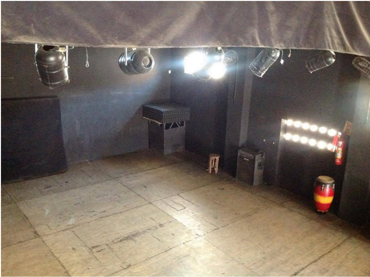
Reforma com troca do compensado naval, do palco – maio de 2017
