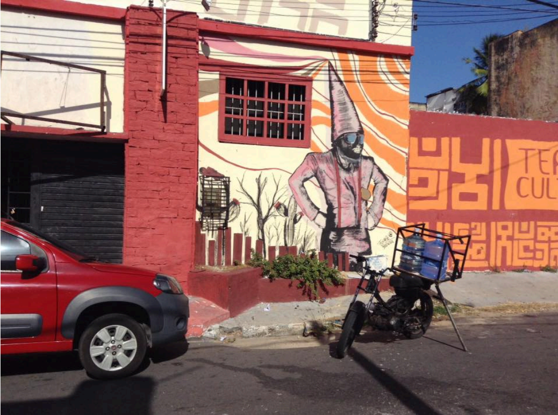
Pintura da fachada em maio de 2017
