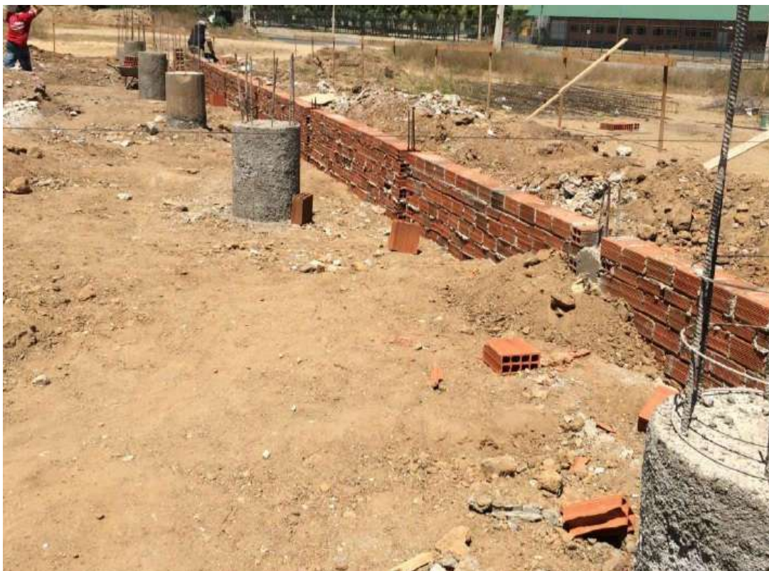
Figura 83: Construção de quadra poliesportiva no bairro Novo Recanto
