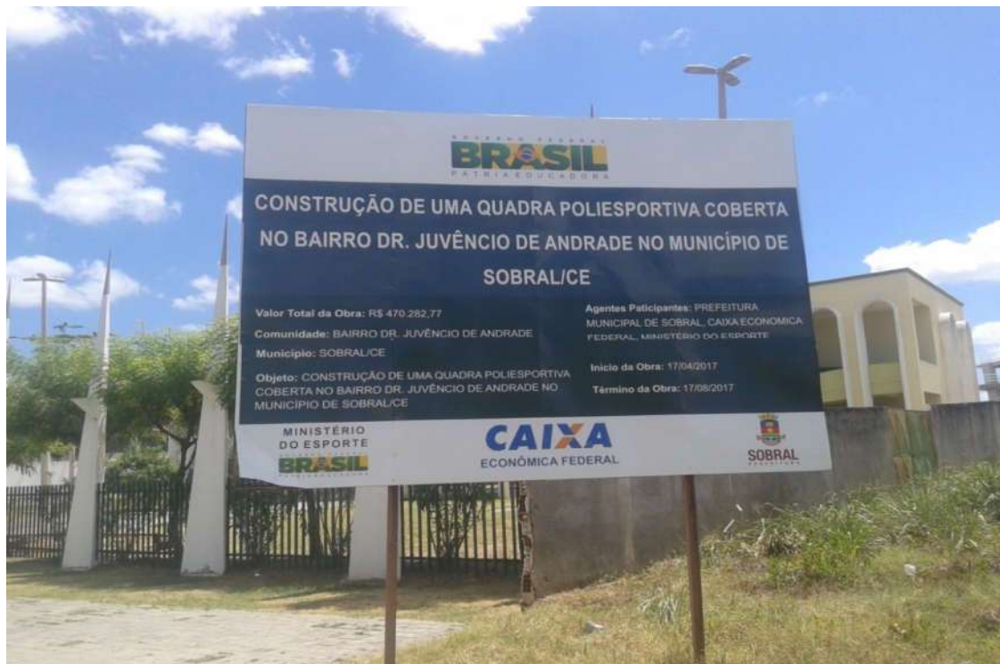
Figura 84: Construção de quadra poliesportiva no bairro Dr. Juvêncio de Andrade
