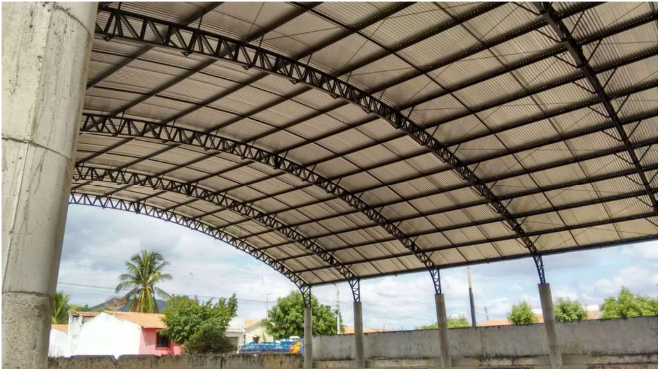
Figura 78: Construção de cobertura da quadra esportiva no distrito de Rafael Arruda
