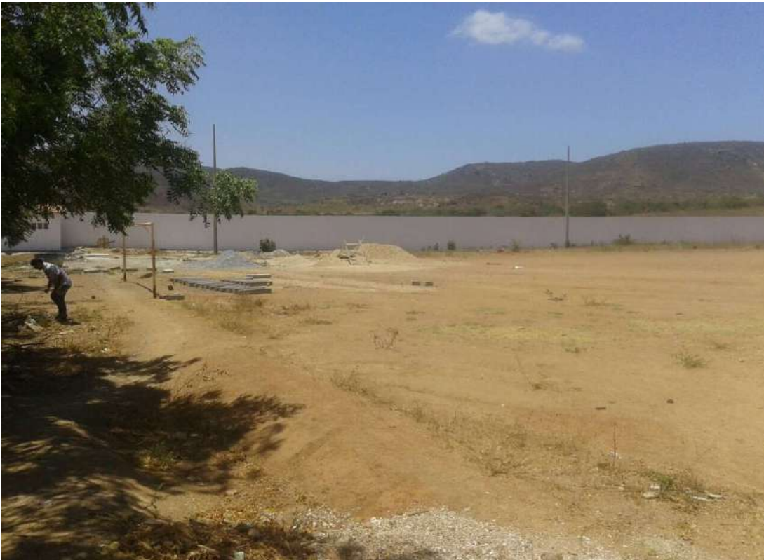
Figura 80: Construção de miniestádio na localidade de São Francisco, distrito de Jordão
